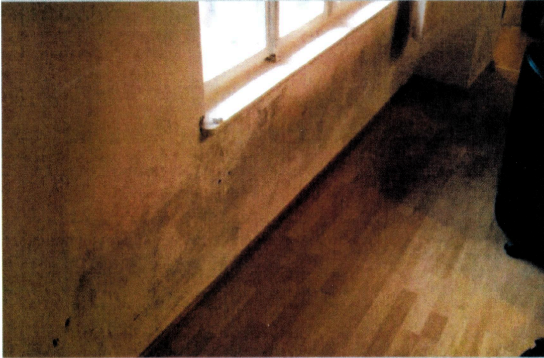
Außenwand am Bach mit innerer Vorsatzschale
